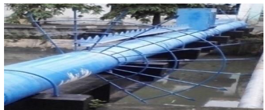
Gambar 3.12 Jembatan Pipa
