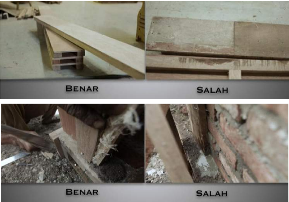
Gambar 54. Kualitas Cetakan/ Bekisting
