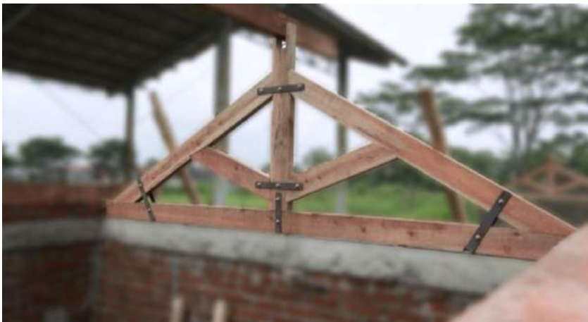
Gambar 28. Kuda-kuda Kayu Dengan Pengikat Plat Baja
