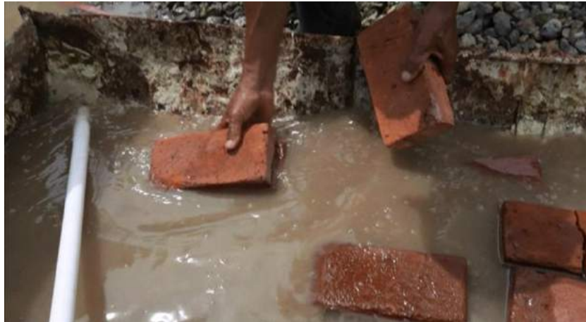
Gambar 15. Perendaman Batu Bata Sebelum Dipasang
