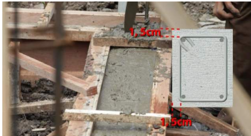
Gambar 19. Balok Pengikat/ Sloof
