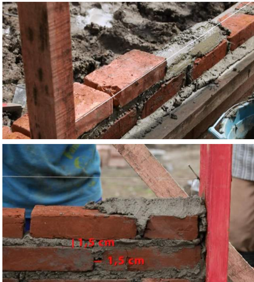
Gambar 41. Proses Pemasangan Batu Bata Untuk Dinding
