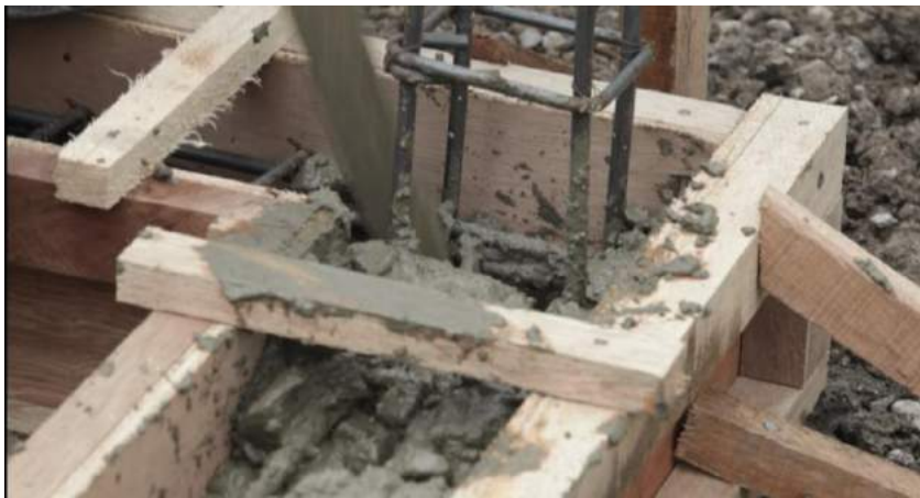
Gambar 58. Pengecoran Balok Pengikat/ Sloof
