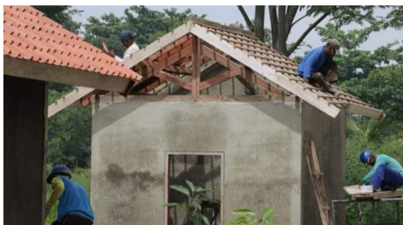
Gambar 27. Kuda-kuda Kayu Pada Atap Rumah Tinggal
