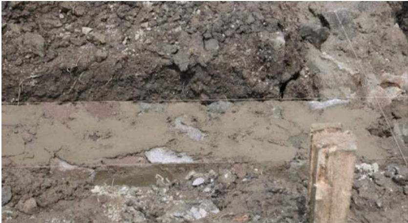
Gambar 11. Pondasi Dari Batu Kali/Gunung
