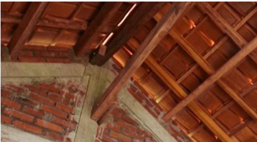
Gambar 37. Pertemuan Antara Ikatan dengan Gunung-Gunung/ Ampig
