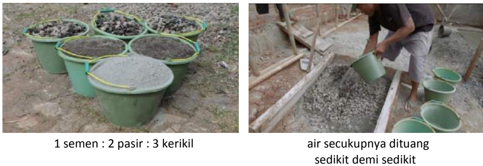
Gambar 2. Pencampuran Beton
