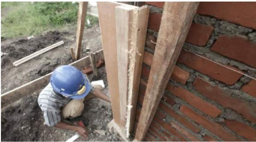
Gambar 55. Pemasangan Cetakan/ Bekisting Untuk Kolom
