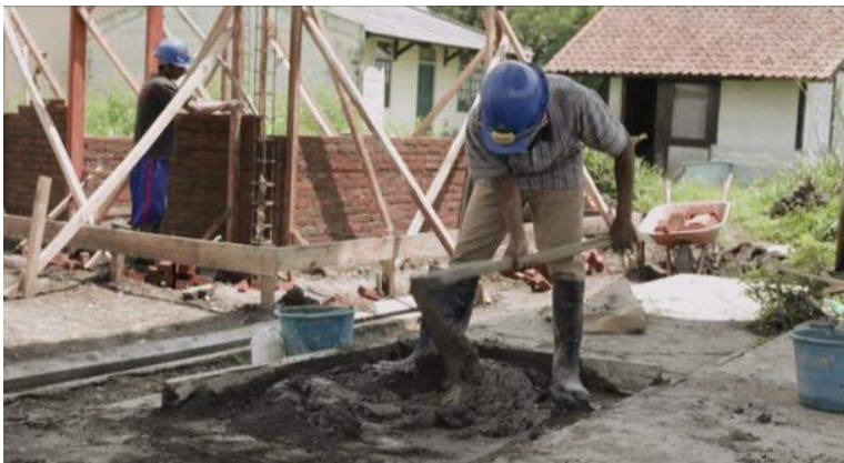
Gambar 8. Proses Pencampuran Mortar
